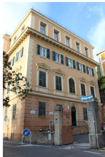
Figura 0.1 - Vista della facciata esposta a sud-est
