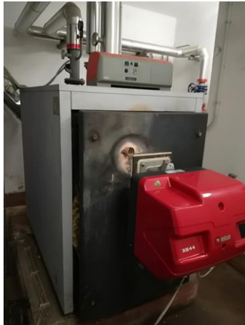
Figura 4.9 - Particolare della caldaia Unical Trisecal 3P 350
