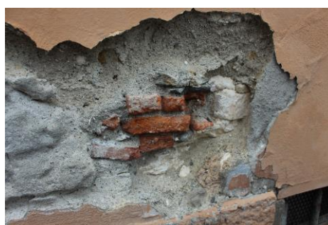
Figura 4.2 - Particolare della facciata in pietra e laterizio
