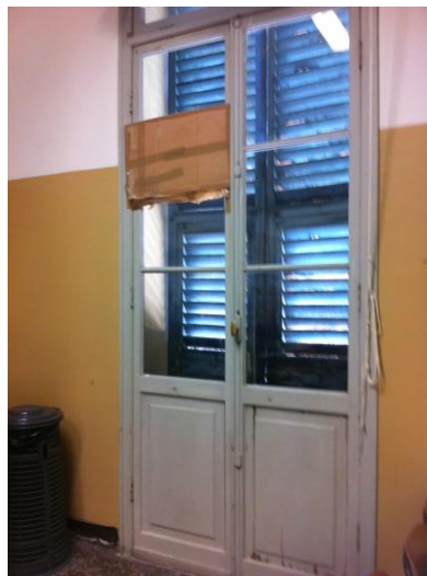
Figura 8.1 - Particolare serramento in legno esistente
