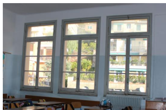
Figura 4.3 - Particolare dei serramenti delle aule in legno con vetro singolo
